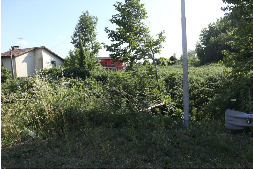
IMMAGINE 29 - VISTA DEL FABBRICATO ANGOLO N-E (mapp. 945)
