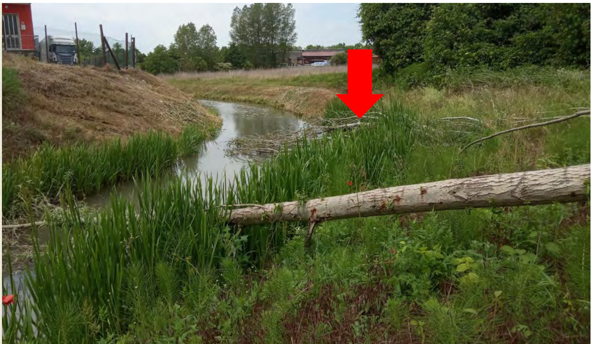
foto del previsto punto di scarico dal bacino al canale consortile (freccia)
