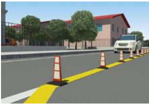
DEVIAZIONE CON LINEA GIALLA E DEFLEKO
