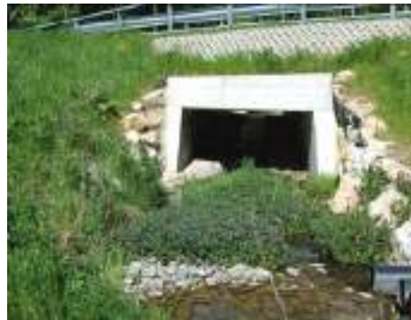
Interventi utili per indirizzare lo spostamento degli animali Esempi di attraversamenti per animali sotto la sede stradale
